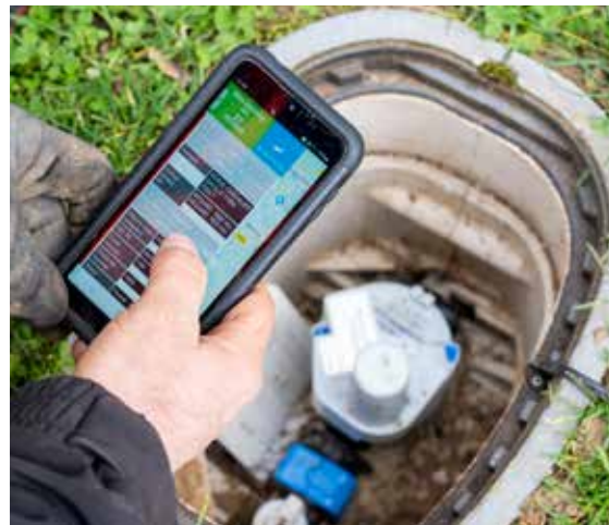
Sur le terrain, nos techniciens utilisent au quotidien des outils digitaux pour piloter les interventions et optimiser la performance des réseaux d'eau.
