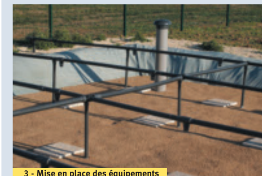
3 - Mise en place des équipements
