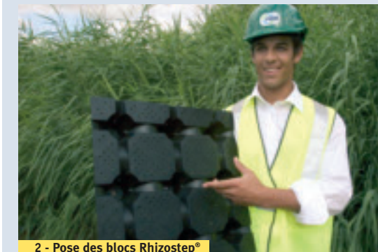
2 - Pose des blocs Rhizostep®
