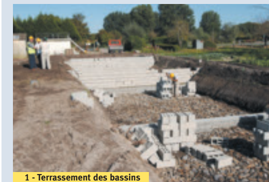
1 - Terrassement des bassins
