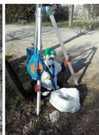
Désobstruction de réseau dans l'Hérault
