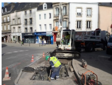
Réparation fuite en Bretagne
