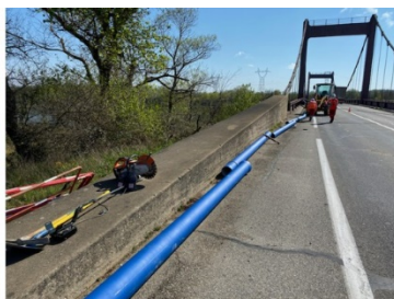
Pose d'une canalisation provisoire dans le Vaucluse
